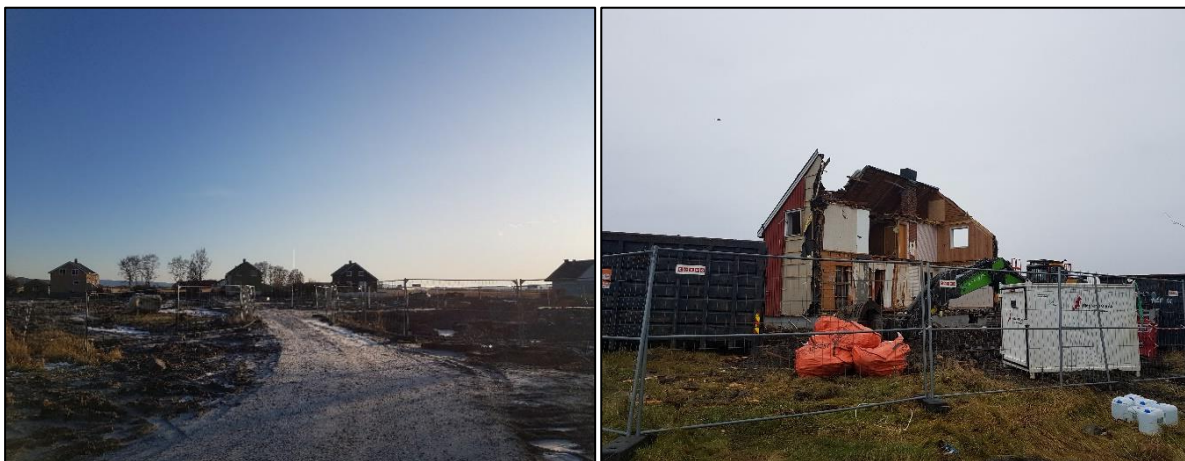
Figur 5: Arbeidet med å rive bolighus i rød støysone var godt i gang høsten 2019. Til venstre er avbildet 'restene' av boligfeltet 'Blomsterbyen' etter at 12 boliger har blitt revet. Foto: Tonje Aarre Sommarset.
